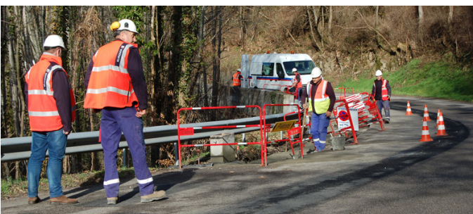
Travaux de voirie
