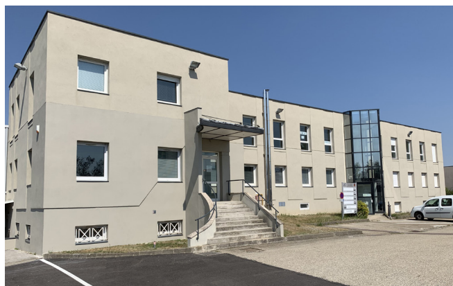
Hôtel d'entreprises - Saint-Just-Malmont
