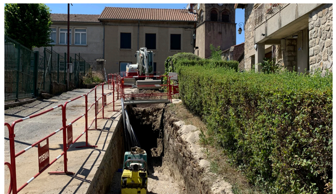
Travaux Boulevard des Jardins - Saint-Didier-en-Velay
