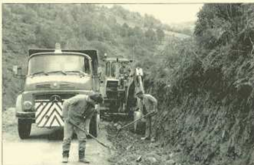
Réfection du chemin de la Cour par les employés communaux.
