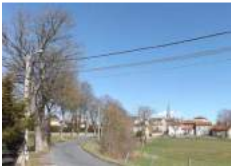
Alignement le long de la RD 231 communale en entrée de bourg Sud
