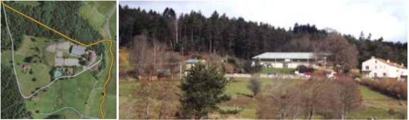
Hameau regroupant le centre équestre, un bâtiment d'habitat collectif et de l'habitat individuel.
