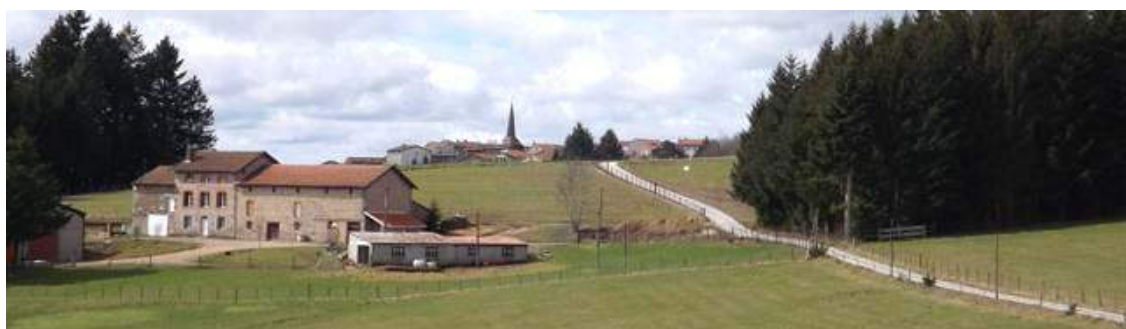
1 Vue sur le bourg depuis l'intersection entre la route de la Bruyère et le chemin de Planchette
