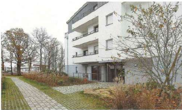
Trallement d'aires perméables à Champagny (85)
