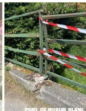
Ils viennent d'être déclarés dangereux et interdits à la circulation. Leurs structures sont profondément fragilisées, les garde-corps en très mauvais état, ils représentent un vrai danger et nécessitent de lourds travaux.
